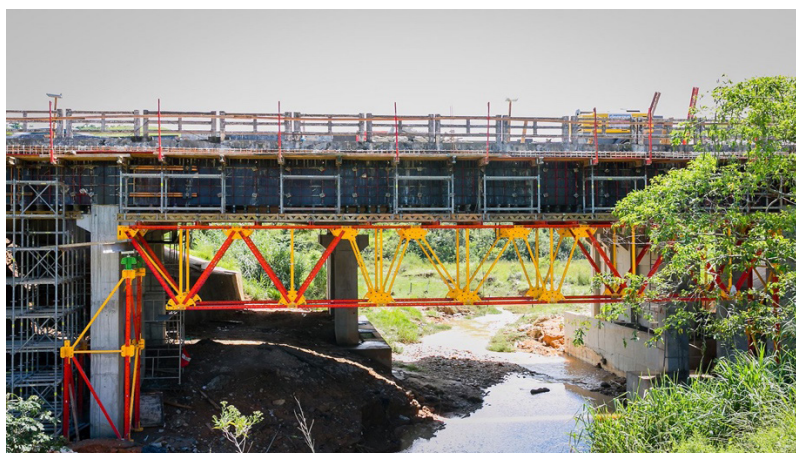
FIGURA 3. Ponte de Treliças.
